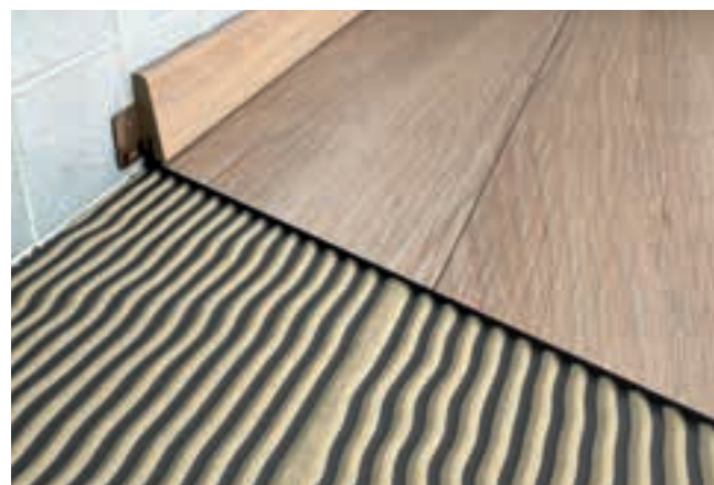
Celoplošné lepení: bezpečné a trvalé zejména při použití v komerční oblasti
